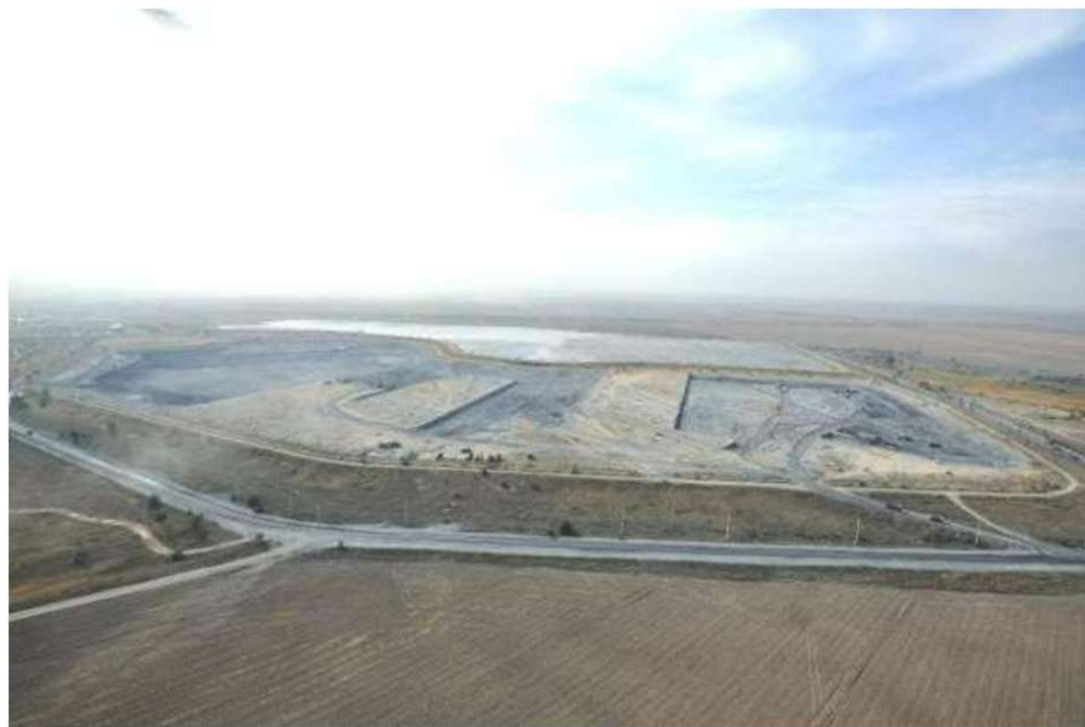
Рисунок 1.4. Общий вид золоотвала ТЭЦ-2
