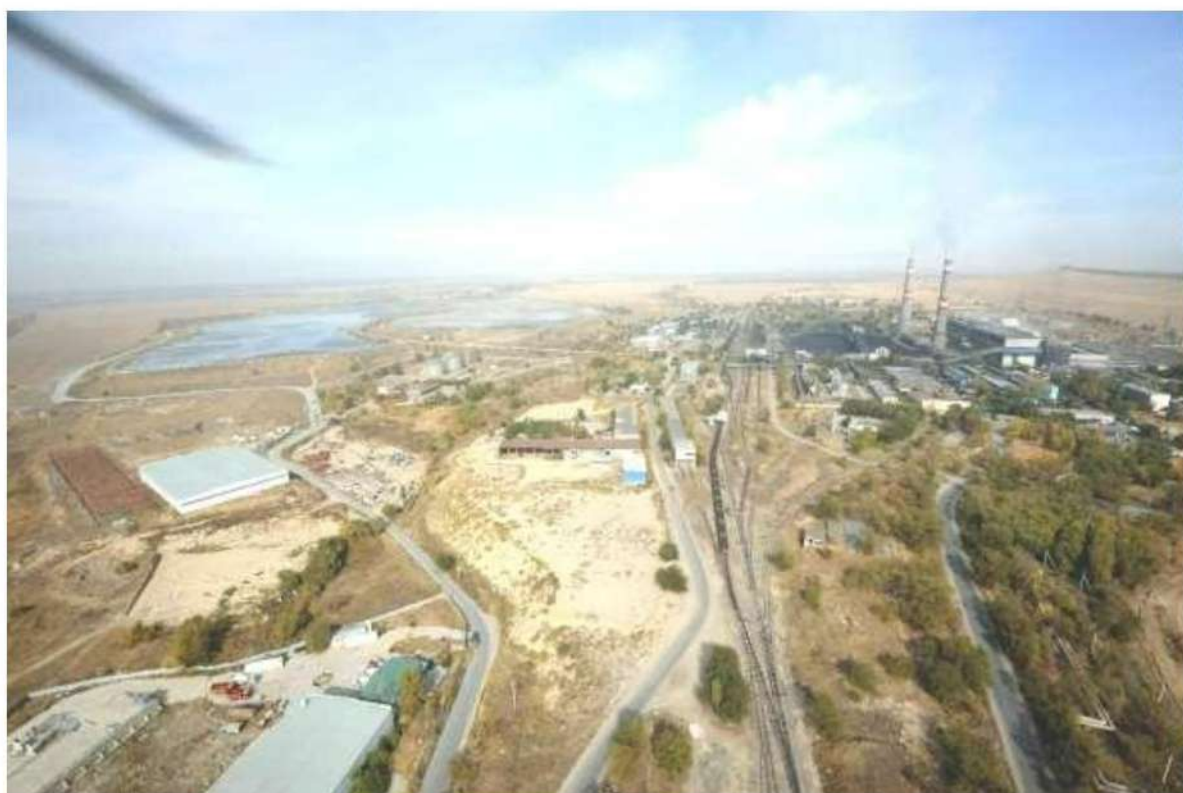
Рисунок 15.3. Общий вид промплощадки ТЭЦ-2
