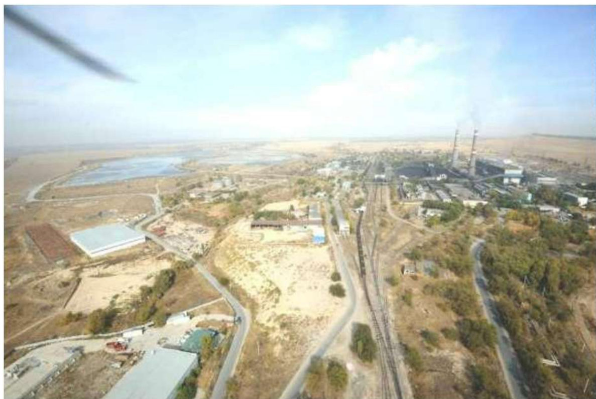
Рисунок 1.3. Общий вид промплощадки ТЭЦ-2
