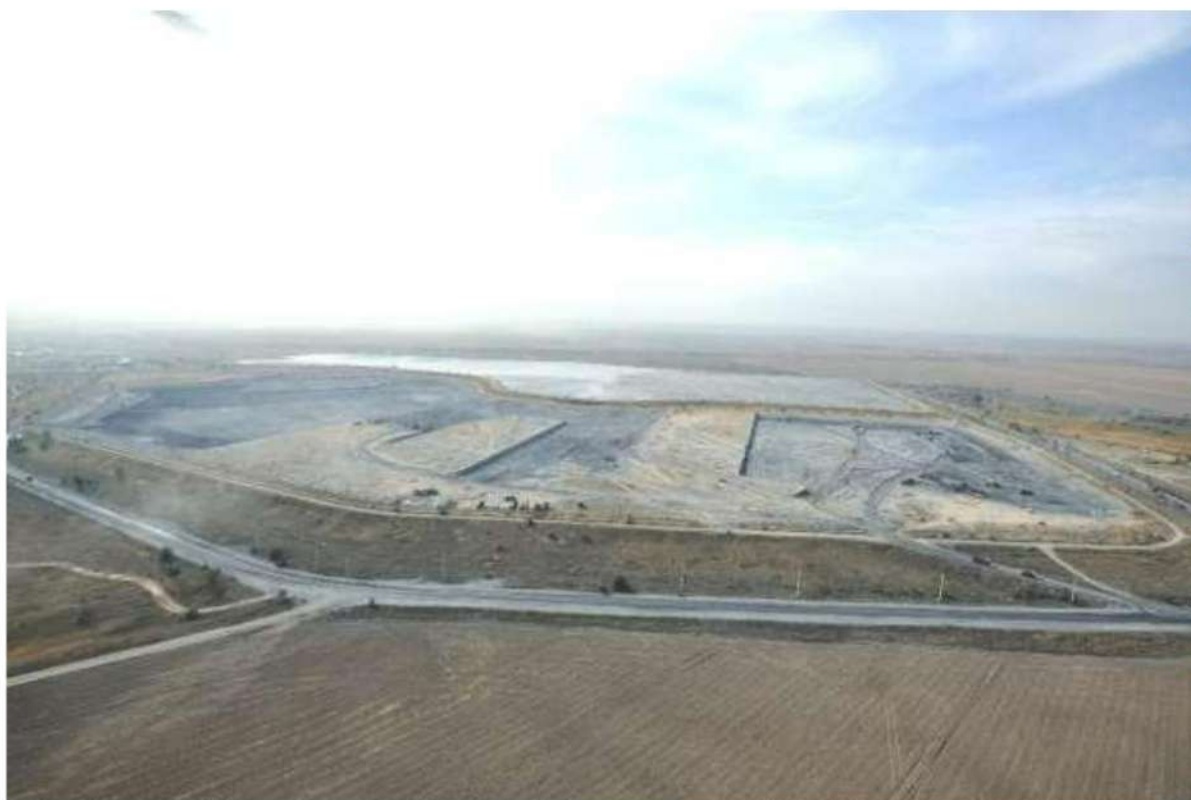
Рисунок 15.4. Общий вид золоотвала ТЭЦ-2
